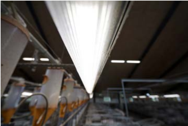
Lámparas limpias de luz fluorescente colocadas cerca de los corrales proporcionan una cantidad óptima de LUX y optimizan el ángulo de luz
