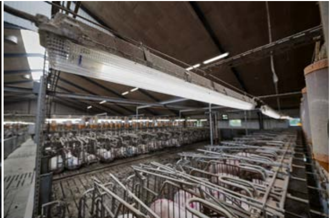
La combinación de iluminación fluorescente y limpia además de tragaluces con luz natural proporcionan una luz óptima para simular el cielo
